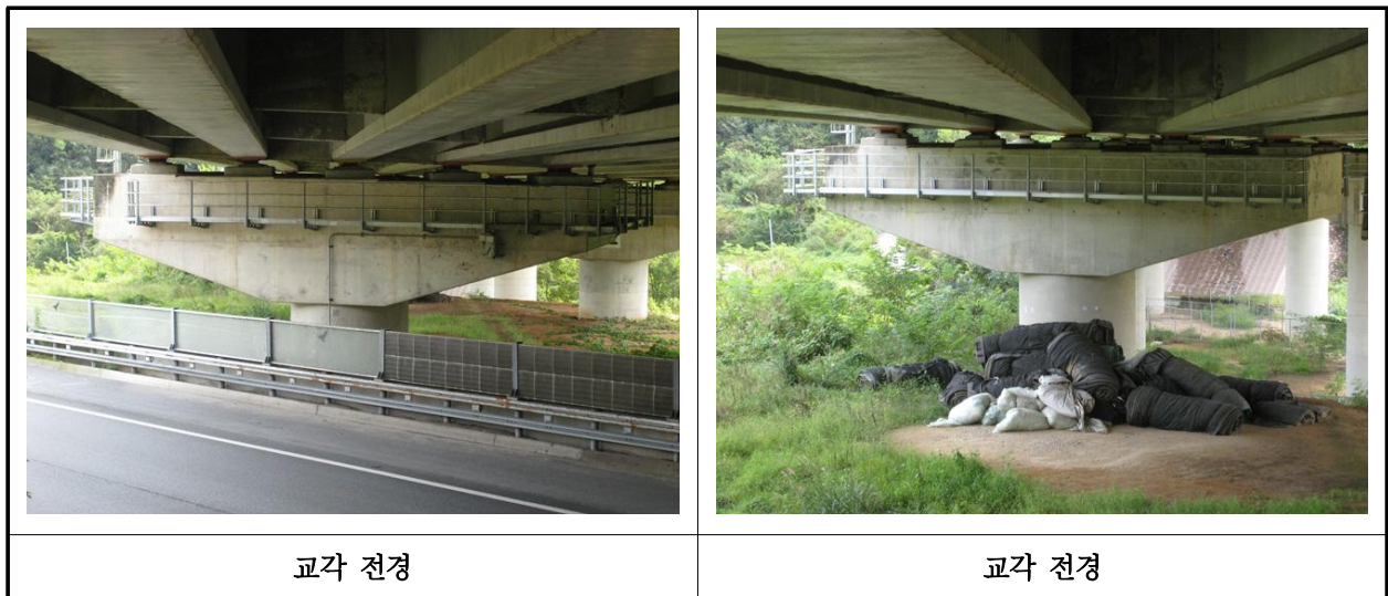
【사진 3.3.10】 교각 전경
