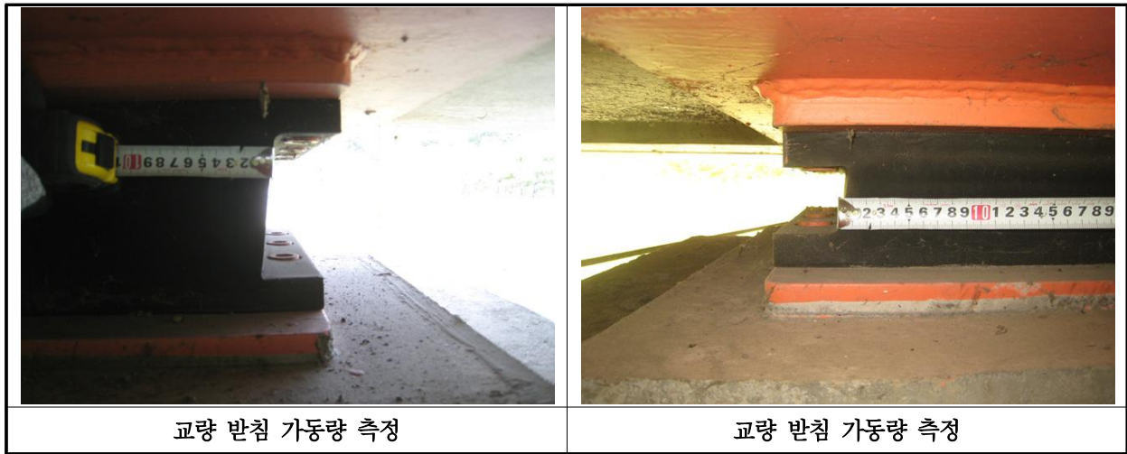
【사진 3.3.15】 교량받침 이동량 측정
