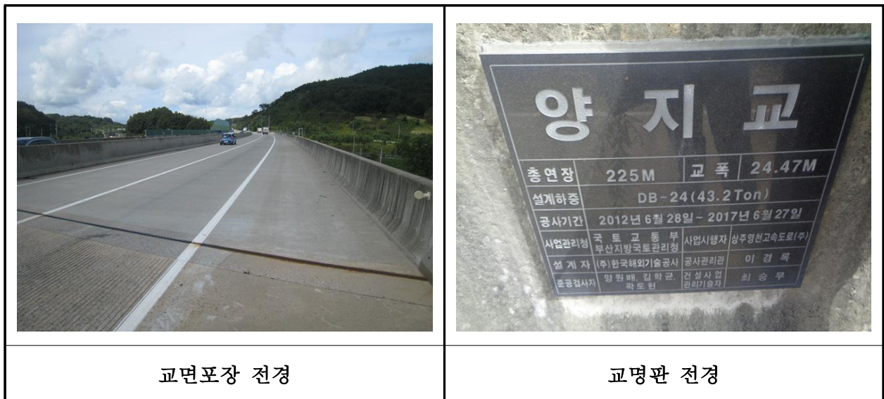
【사진 3.3.19】 교면포장 전경
