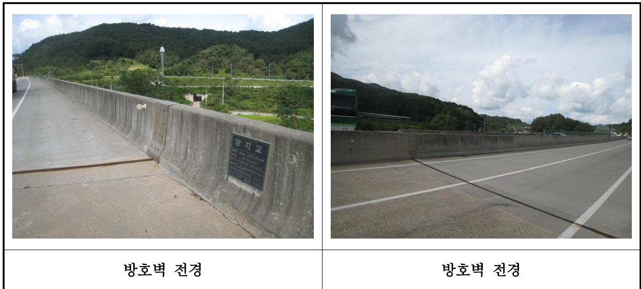
【사진 3.3.23】 방호벽 및 중앙분리대 전경
