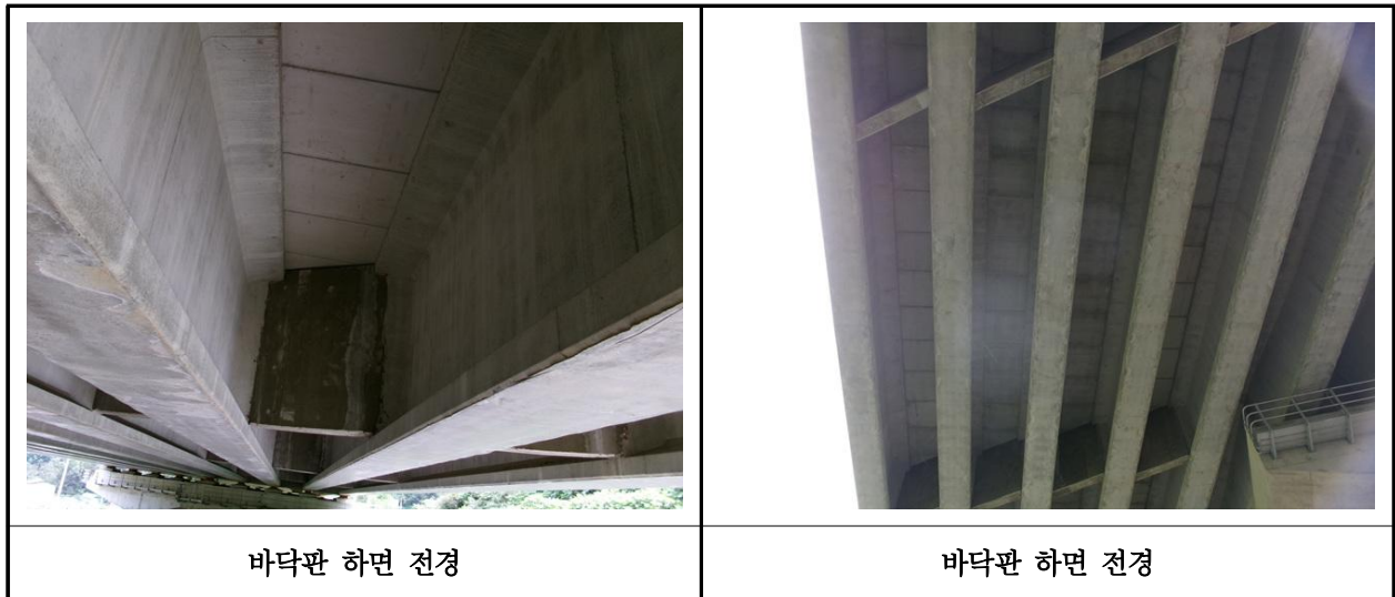
【사진 3.3.27】 바닥판하면 전경
