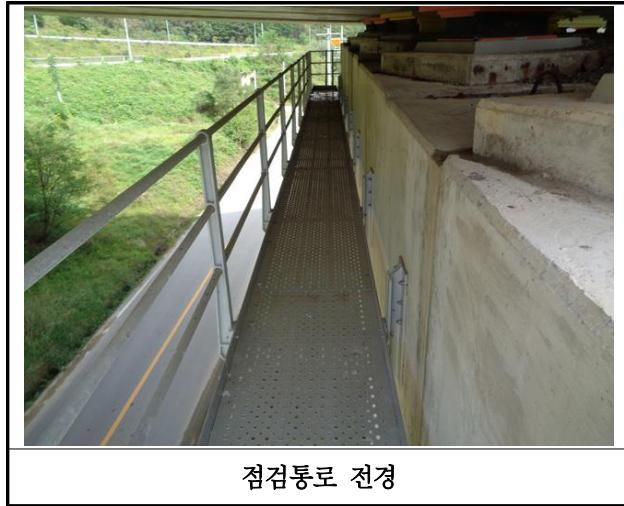
【사진 3.3.50】 교량 점검시설 전경
