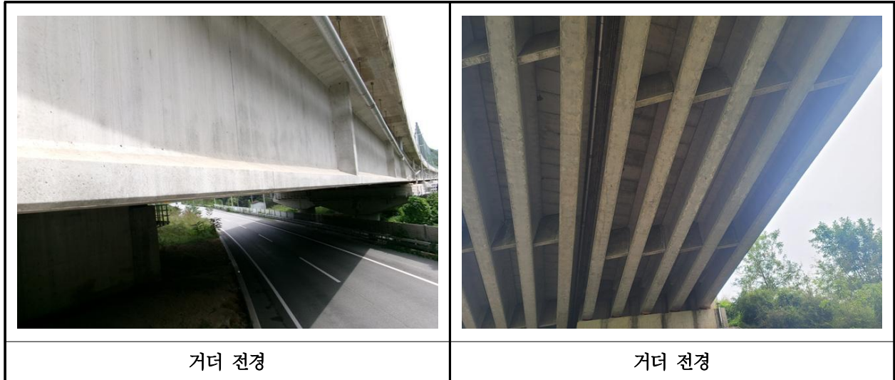
【사진 3.3.29】 거더 전경
