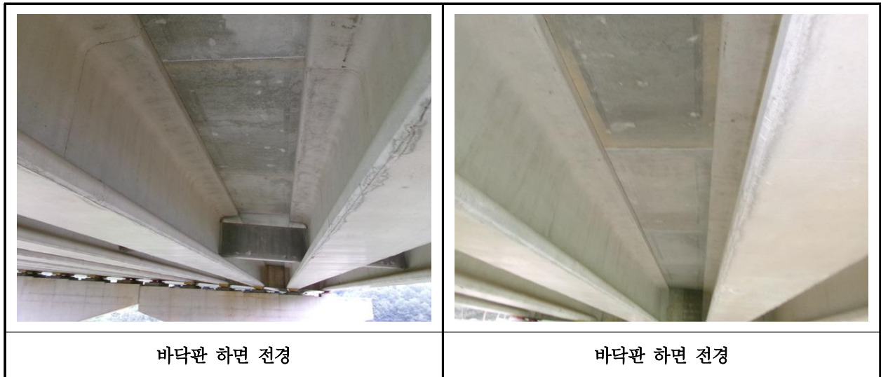
【사진 3.3.2】 바닥판하면 전경
