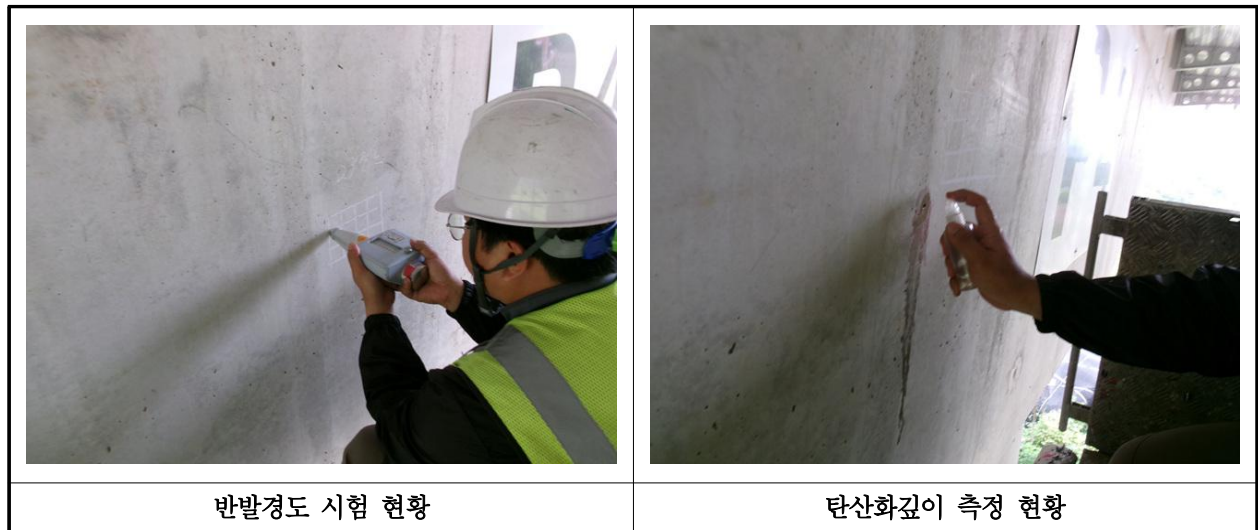
【사진 3.4.1】 콘크리트 내구성조사 현황
