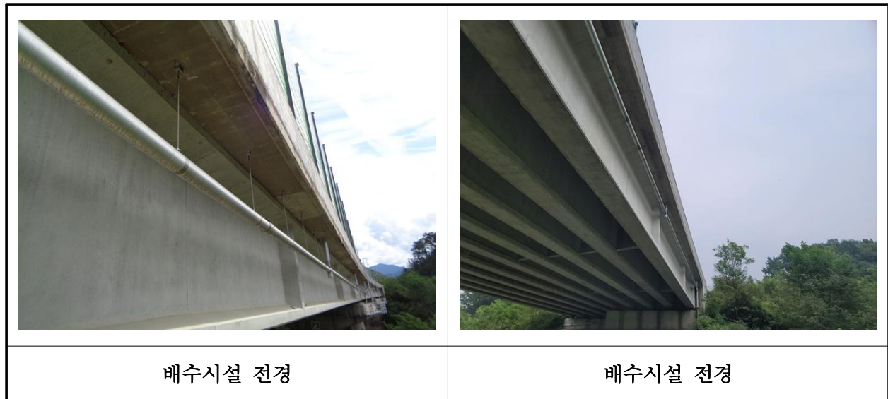
【사진 3.3.46】 배수시설 전경
