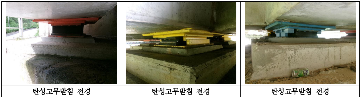
【사진 3.3.37】 교량받침 전경
