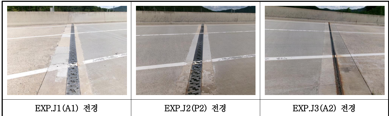
【사진 3.3.41】 신축이음장치 전경
