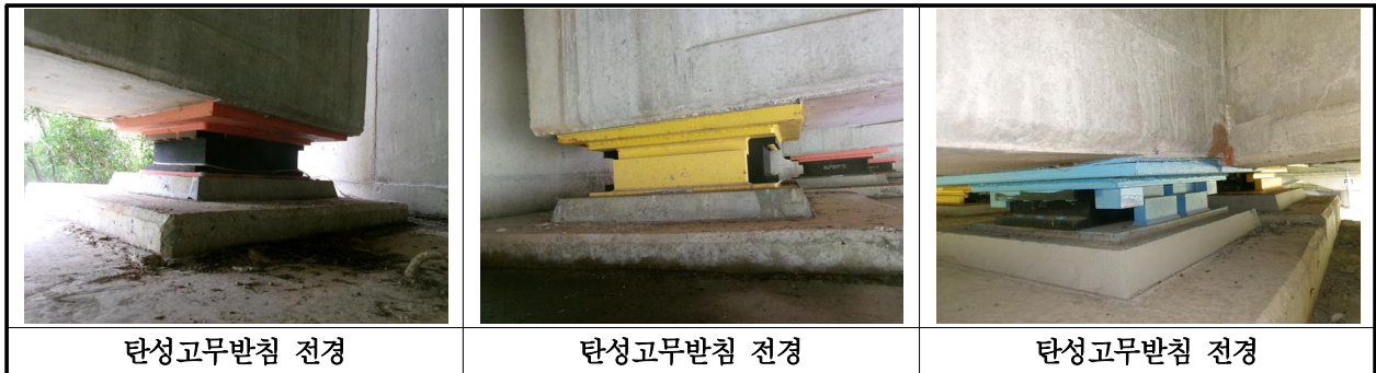
【사진 3.3.12】 교량받침 전경
