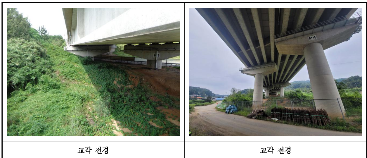
【사진 3.3.35】 교각 전경
