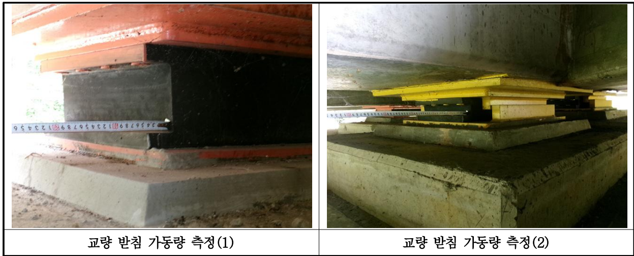
【사진 3.3.40】 교량받침 이동량 측정
