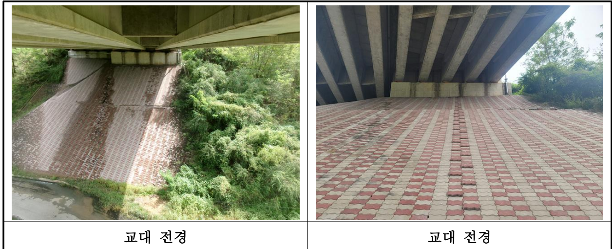
【사진 3.3.33】 교대 전경
