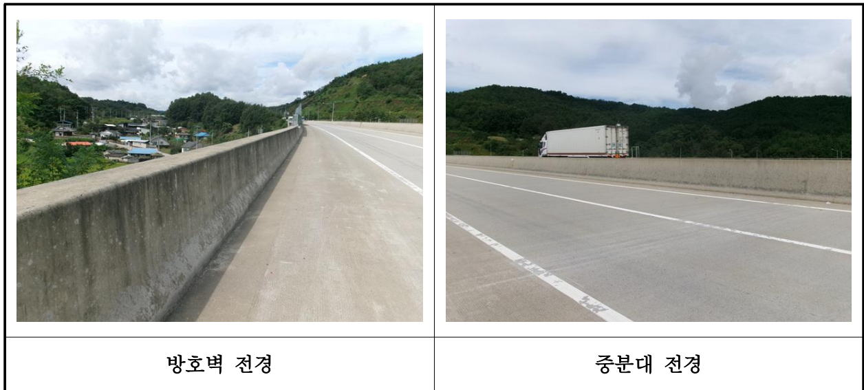
【사진 3.3.48】 방호벽 및 중앙분리대 전경
