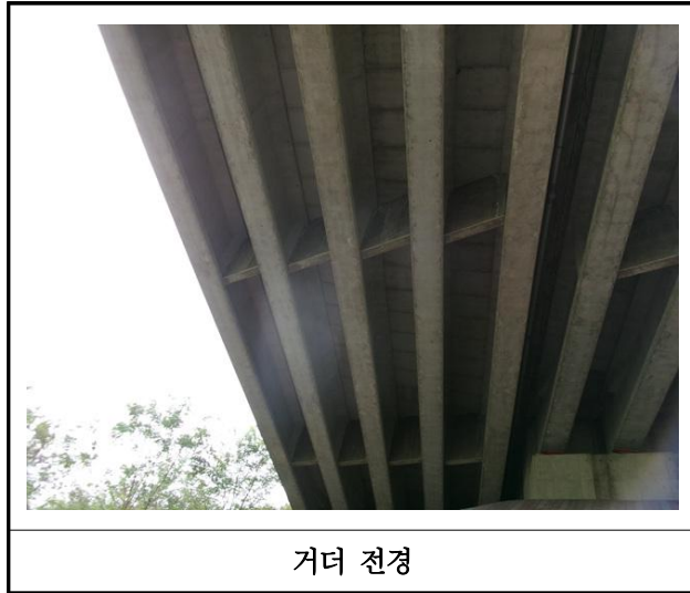
【사진 3.3.4】 거더 전경
