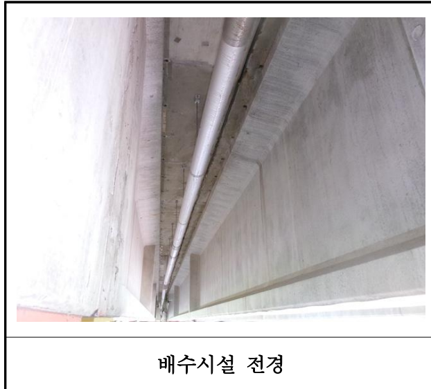
【사진 3.3.21】 배수시설 전경
